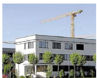
Auf Phoenix-West wird viel gebaut. Auch der IT-Dienstleister SMF reagiert auf das Wachstum und baut an, um mehr Büros zu schaffen. FOTO SMF
